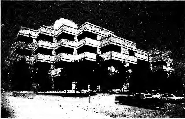
صورة (٣٦): منظر خارجي لمكتبة جامعية لاحظ قرب المواقف من المبنى
